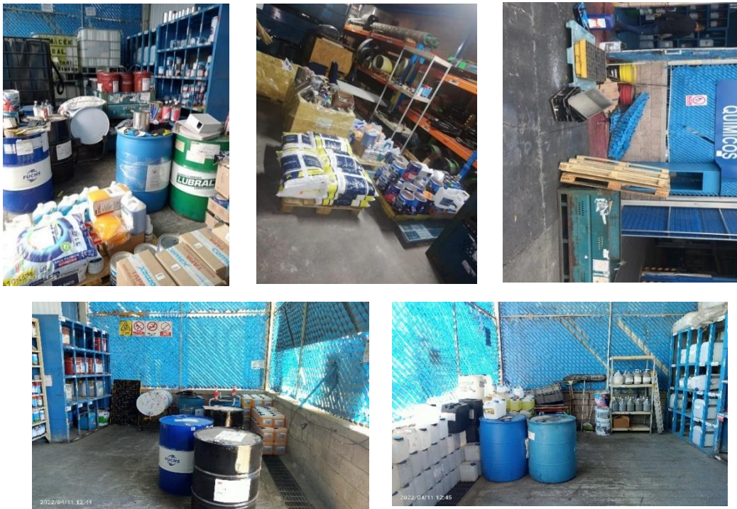
Ilustración 3. Detección de hallazgos en almacén de químicos. Fuente: Almacén de Químicos, 2022.
