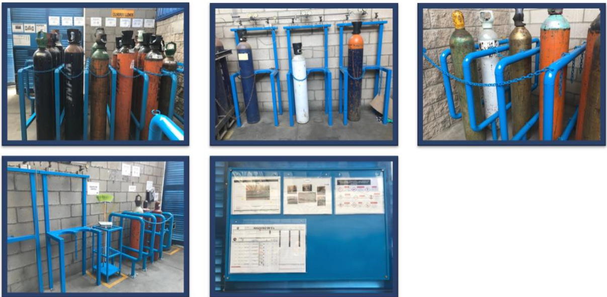
Ilustración 7.1: Almacén de Gas LP.
